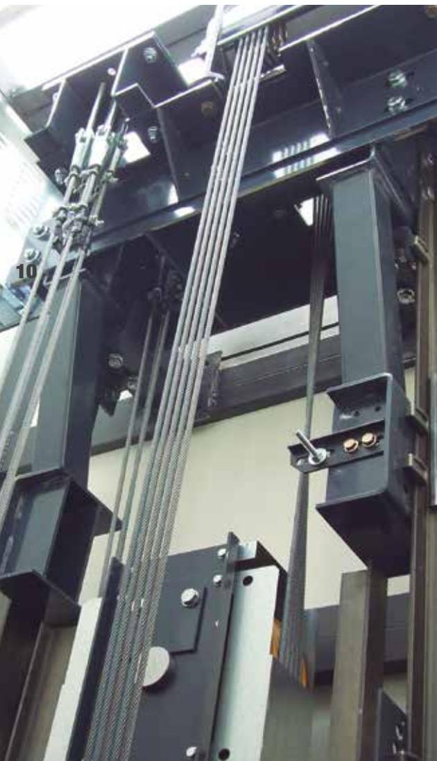
Con el OPTIMUS de Raloe el espacio no nos obliga a instalar ascensores hidráulicos en edificios existentes. OPTIMUS aprovecha el hueco igual que un hidráulico.
