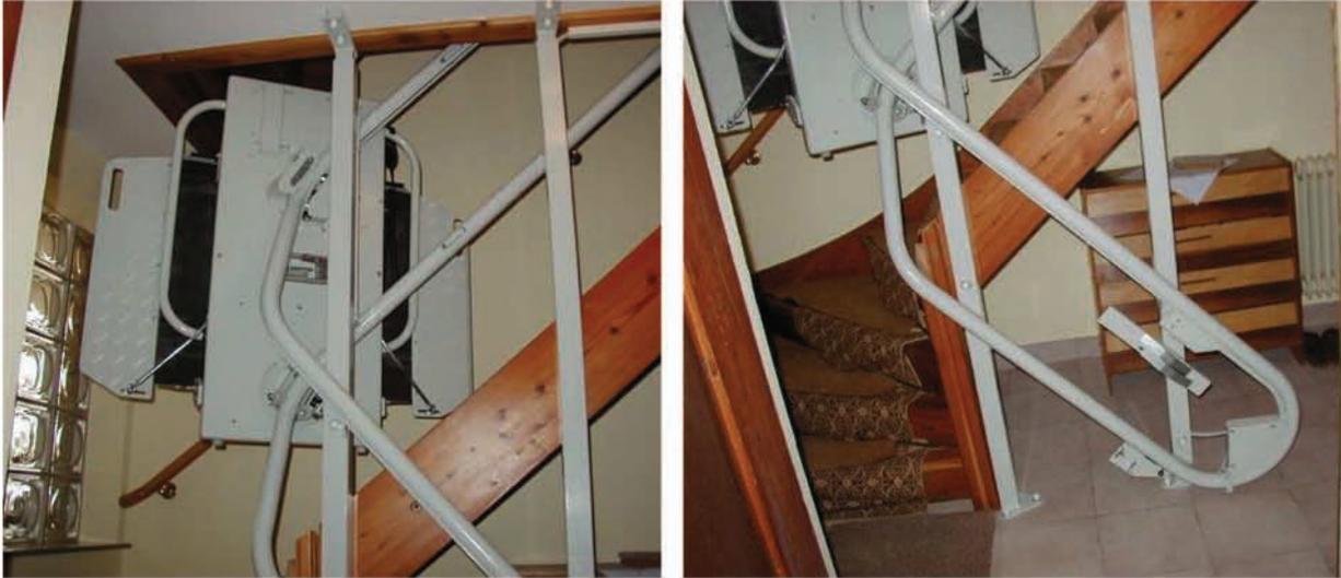
Los raíles pueden adaptarse suavemente a cualquier forma y radio según el diseño de escalera.
